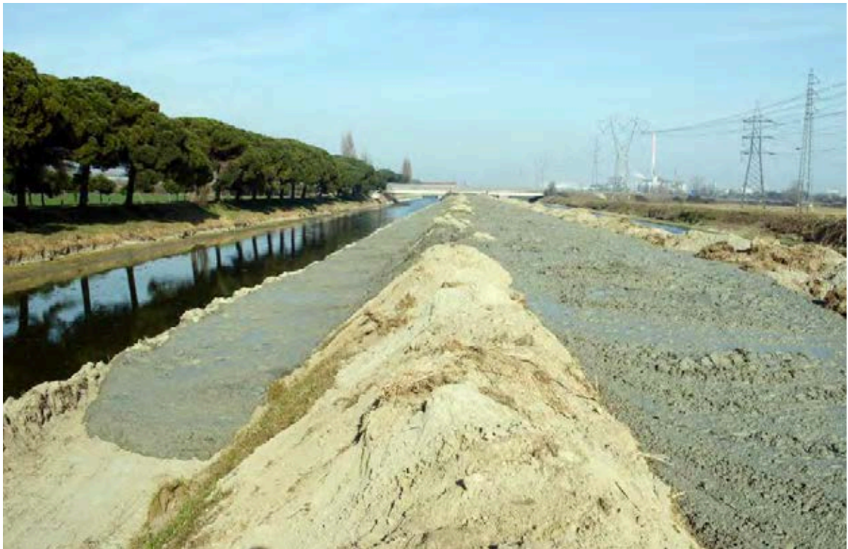
Lavori sul Canale Magni, marzo 2019 ↑
