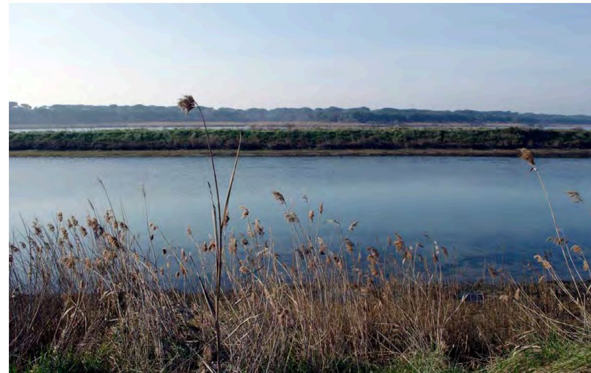
Argini presso la Pialassa Baiona, marzo 2019 ↑
