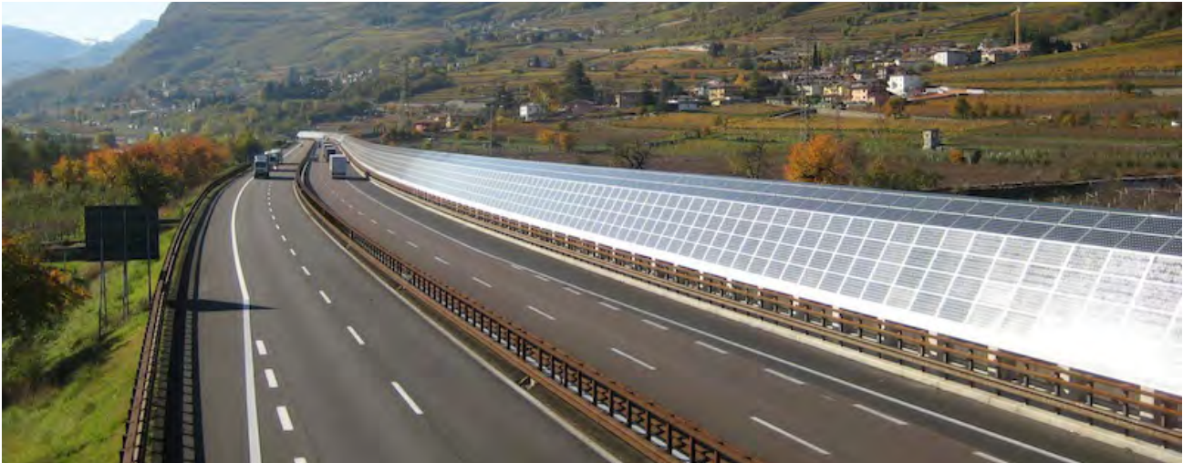
Impianto fotovoltaico sull'autostrada del Brennero ↑
