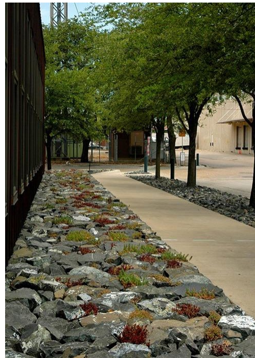
Trincea drenante per raccolta acque copertura
