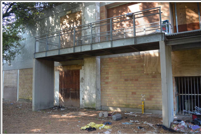
10. Fronte sul giardino
