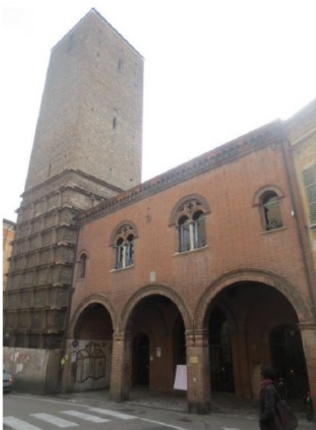
Immagine 3: Prospetto esterno su Via Ponte Marino
