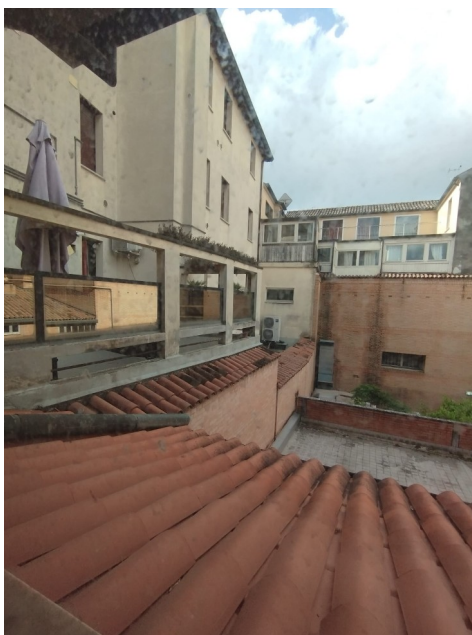
Foto 31: Vista verso corte interna
