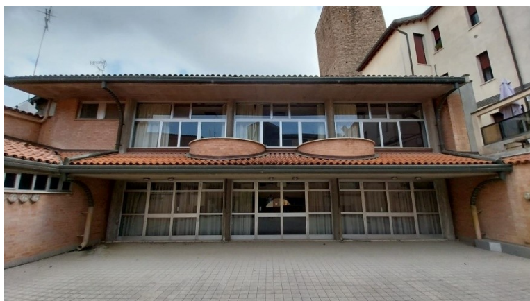
Foto 16: Terrazzo del piano soppalcato (verso corte interna)
