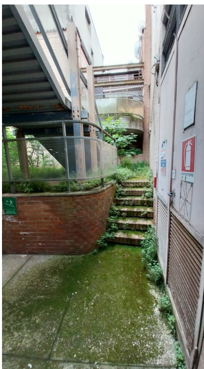
Foto 12: Centrale Termica (corte interna)
