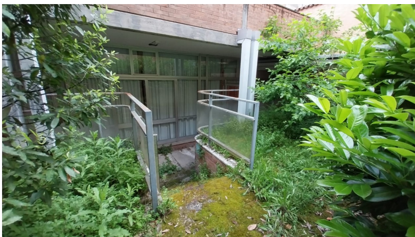
Foto 13: Corte interna sul retro (piano terra)
