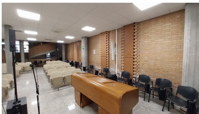
Foto 10: Sala Conferenze (dettaglio colonne impianti)
