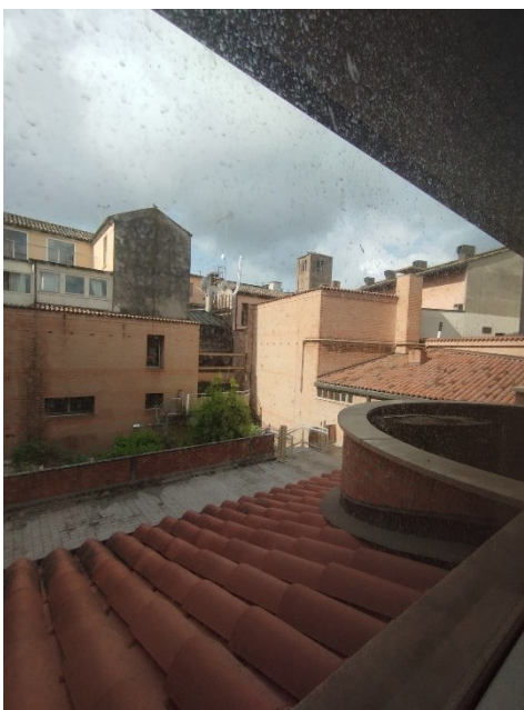
Foto 32: Vista verso corte interna
